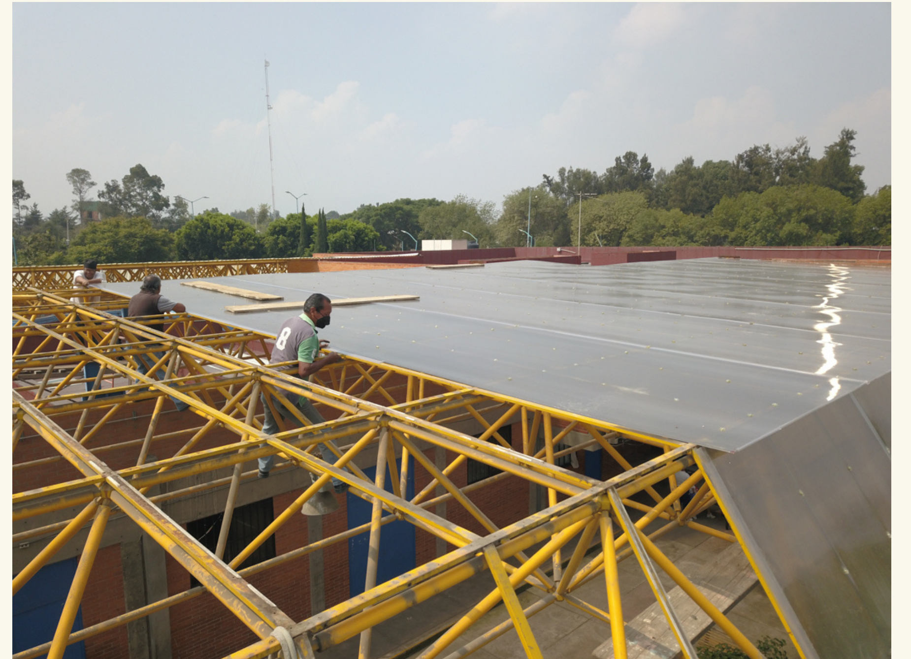
Colocación de láminas en los techos
