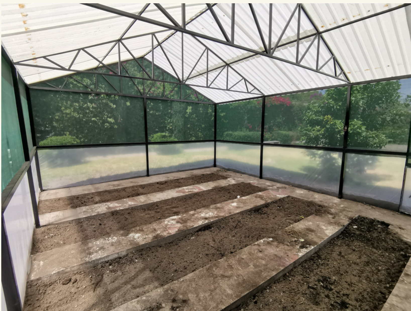
Interior del invernadero ya remodelado
